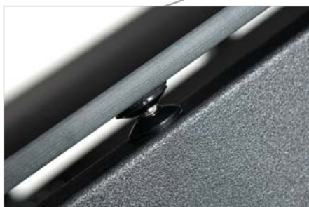
Isolamento dell'SE tra il telaio e il vetro
